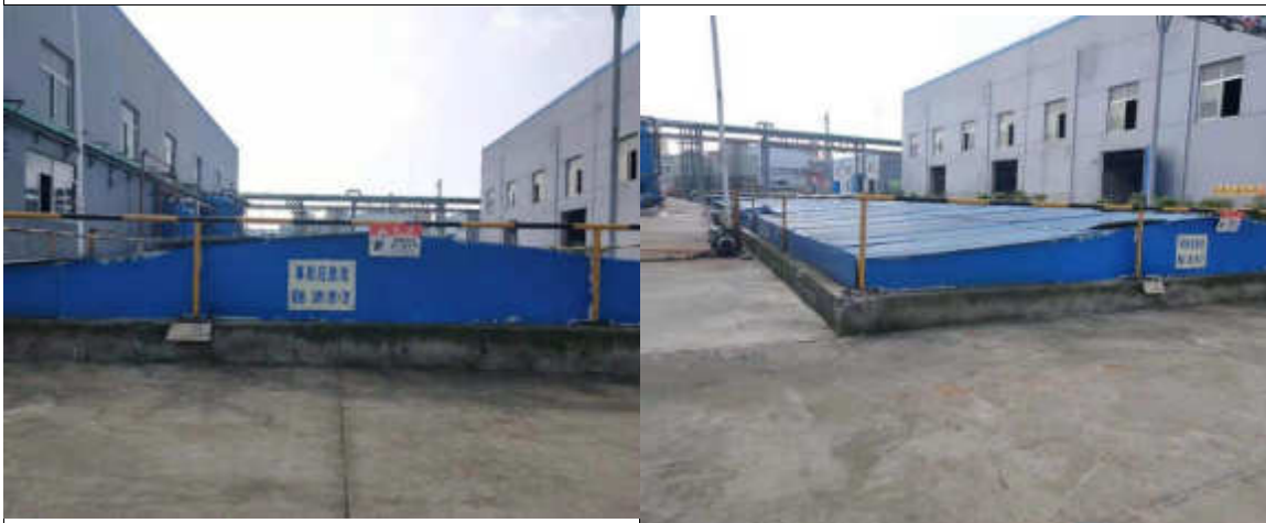
污水处理区：地面均已硬化，无破损，四周设有围堰，导排沟。
