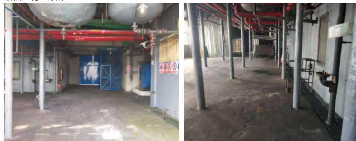
永固紫合成车间：完成烷基化，硝化，加氢，缩合闭环反应生成粗品永固紫，车间地面均已硬化，无明显裂缝。
