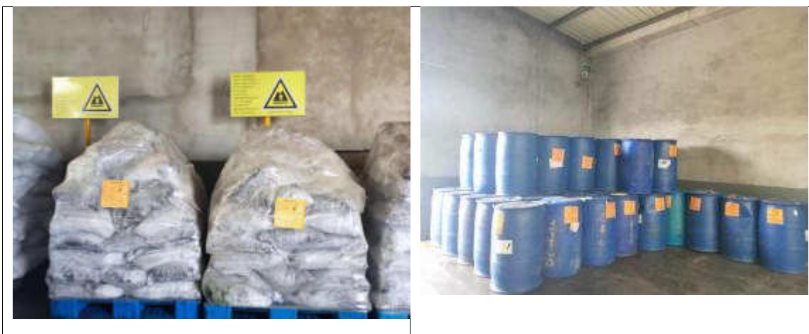
危废仓库：危险固废暂存库位于厂区西北侧，主要用于堆存水处理污泥、废活性炭等危险废物。地面已按照要求采用防腐防渗的环氧地坪，四周设有导排沟，地面无明显破损。
