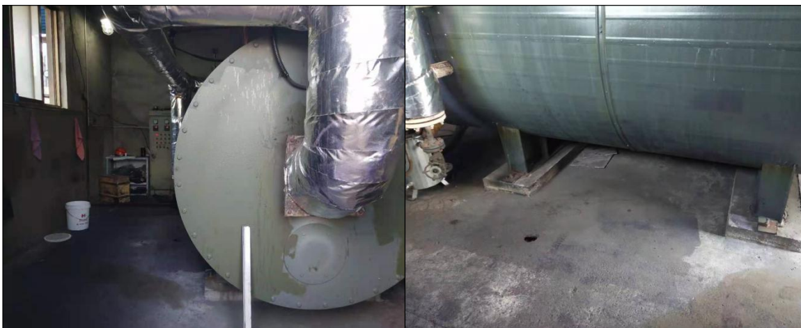
锅炉房：地面均已硬化，无明显裂痕。
