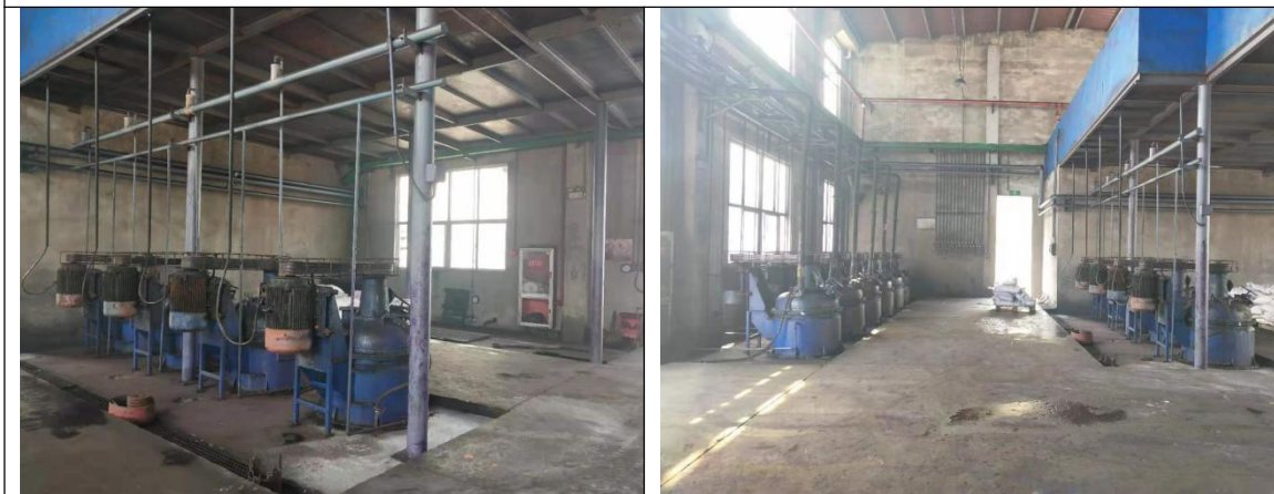
永固紫球磨车间：粗品永固紫紫研磨颜料化和粉碎干燥，车间地面均已硬化，无明显裂缝。
