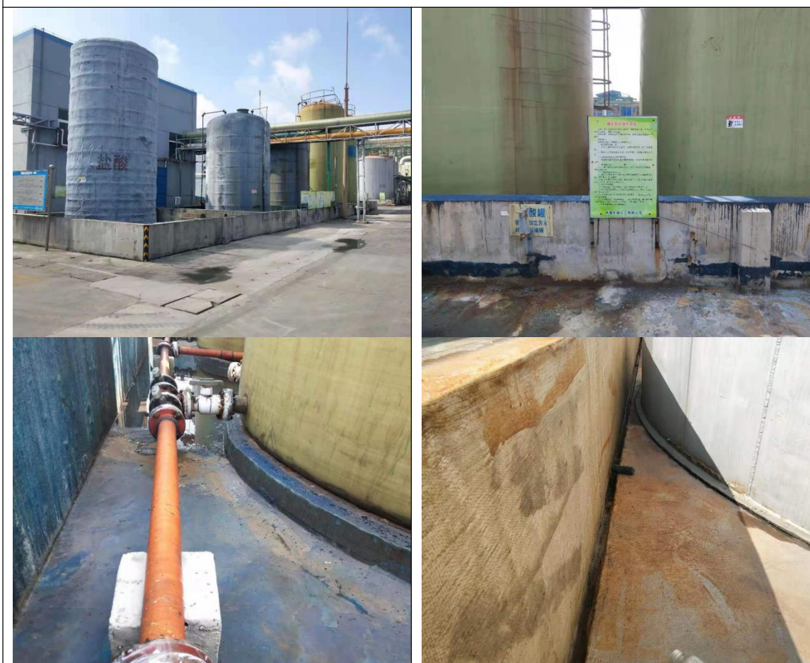
酸碱罐区：盐酸、液碱储罐区地面已做防腐防渗处理，四周设有围堰、导排沟，地面无破损。
