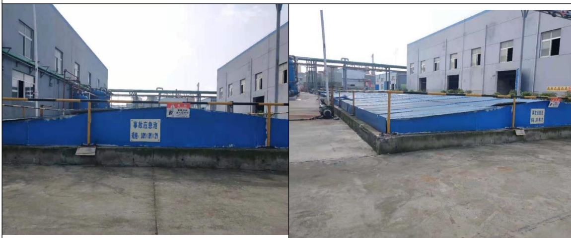
污水处理区：地面均已硬化，无破损，四周设有围堰，导排沟。
